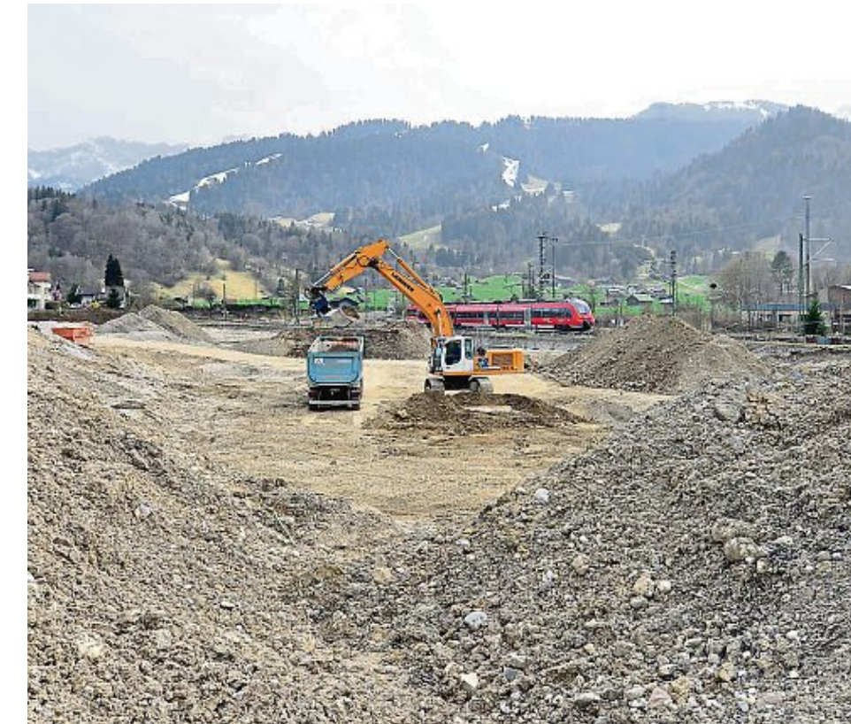
In den letzten Zügen: Der Aushub auf dem Gelände zwischen Bahnhof, Lagerhausstraße, Wanerweg und Bahngleisen ist nahezu abgeschlossen.
